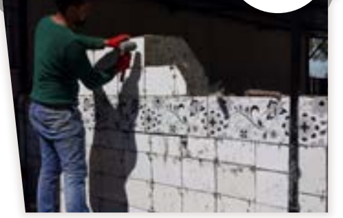
Okulumuza Çeşme Yapımı
